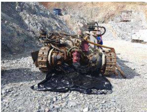
Foto 137 – Perfuratriz parada na frente de serviço proteção de lona. (Data:30/08/2021)
