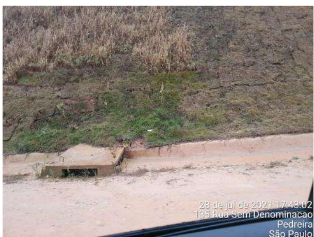
Foto 361 – Inspeção em drenagem da MD03 em dia de chuva. (Data:28/07/2021)
