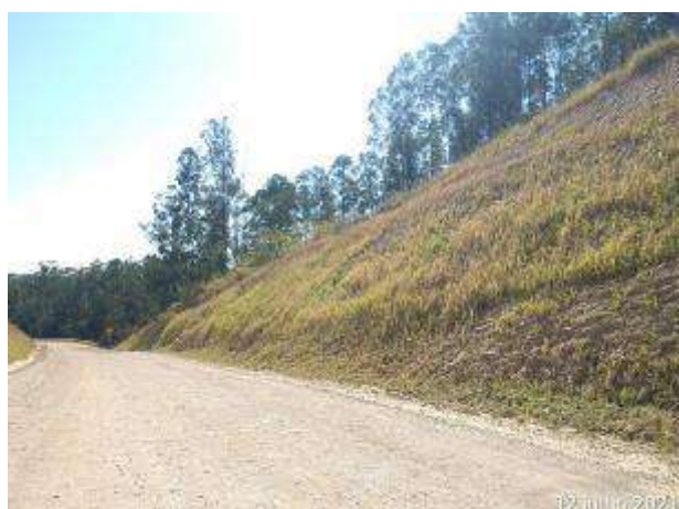
Foto 358 – Inspeção de talude – MD03. (Data:12/07/2021)
