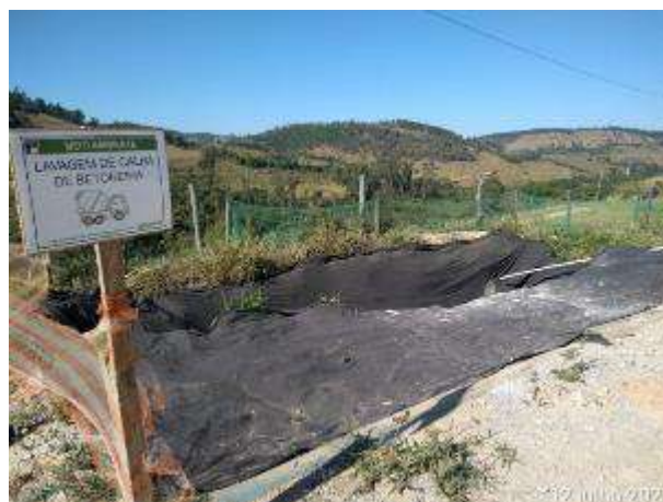
Foto 383 – Dispositivo de drenagem para efluente de lavagem de betoneira. (Data:12/07/2021)
