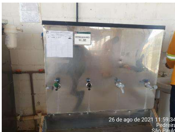
Foto 198 – Controle de higienização do bebedouro 3 no canteiro operacional. (Data:26/08/2021)
