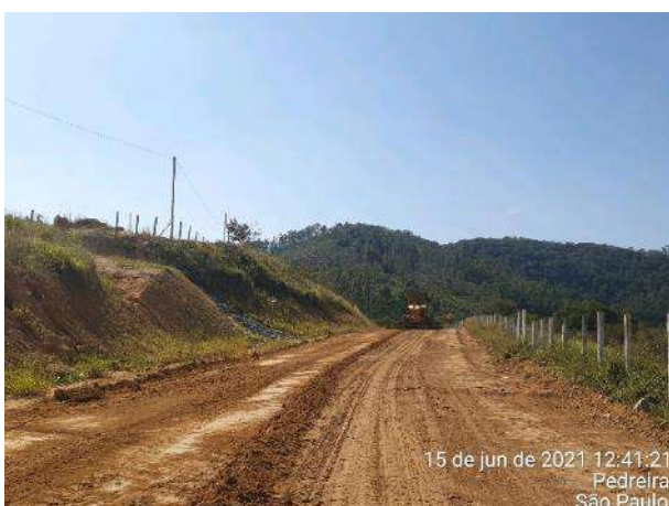
Foto 288 – Melhoria de via externa – MD01. (Data:15/06/2021)
