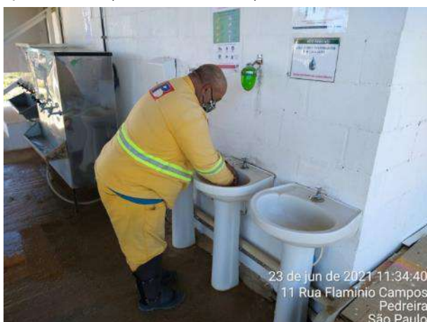
Foto 242 – Local para higienização das mãos na área de vivência – canteiro operacional. (Data:23/06/2021)
