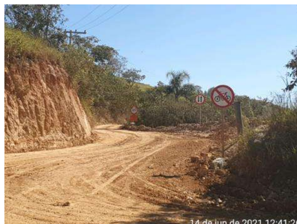
Foto 307 – Sinalização de proibido bicicleta na via - margem esquerda. (Data:14/06/2021)
