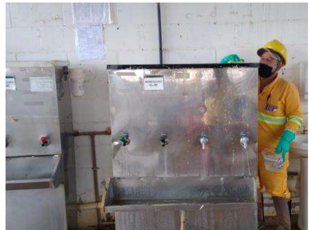
Foto 185 – Limpeza e higienização de bebedouro no canteiro operacional. (Data:14/05/2021)
