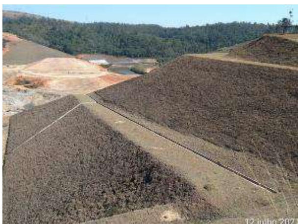
Foto 336 – Grama do talude da margem direita. (Data:12/07/2021)
