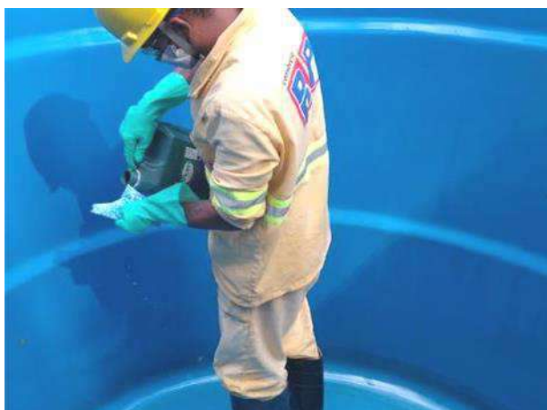
Foto 186 – Higienização de caixa d'água no canteiro administrativo. (Data:14/05/2021)
