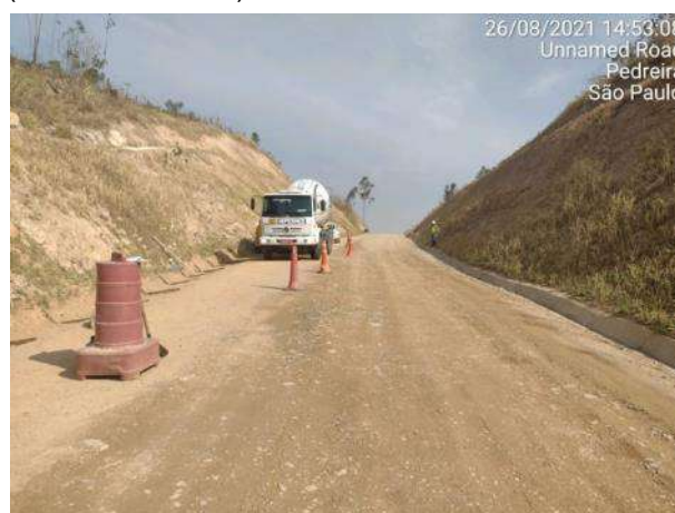
Foto 295 – Isolamento para atividade de concretagem das canaletas – MD03. (Data:26/08/2021)
