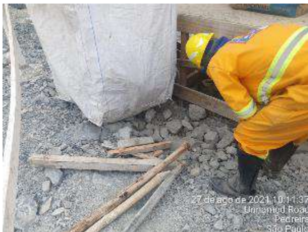
Foto 178 – Limpeza da estrutura de armazenamento de cimento na frente de serviço da fundação. (Data:27/08/2021)
