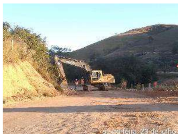
Foto 359 – Manutenção em bueiro no acesso a área do eixo. (Data:23/07/2021)
