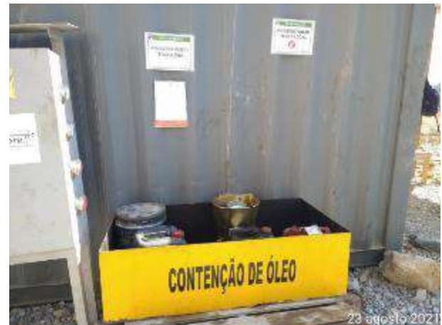
Foto 134 – Produtos químicos dispostos na frente de serviço com a bacia de contenção. (Data:23/08/2021)
