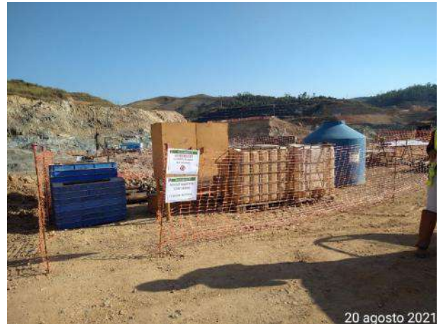
Foto 175 – Organização no armazenamento temporário dos materiais da empresa Sondsolo. (Data:20/08/2021)
