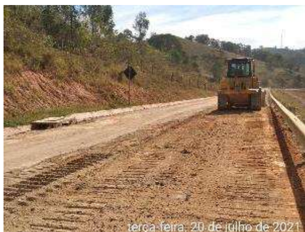
Foto 292 – Melhoria de via externa – MD03. (Data:20/07/2021)
