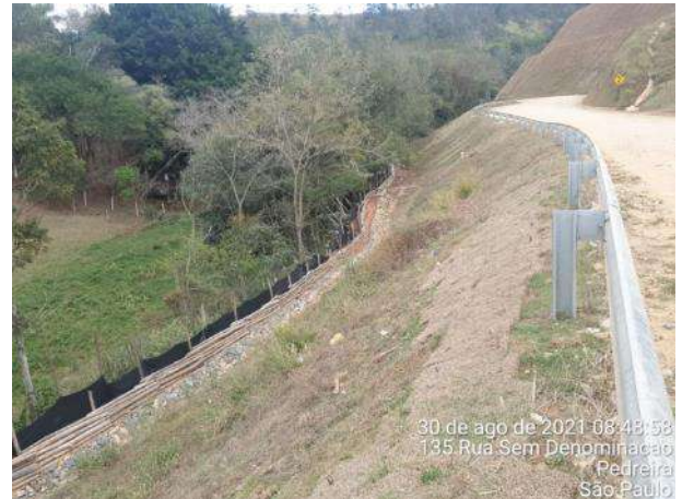
Foto 369 – Inspeção de talude e contenção ambiental – MD03. (Data:30/08/2021)
