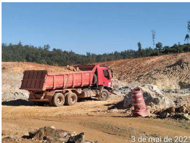
Foto 476 – Movimentação de terra - margem direita. (Data:03/05/2021)
