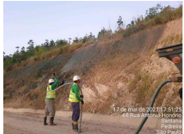
Foto 319 – Hidrossemeadura no acesso MD03. (Data:17/05/2021)
