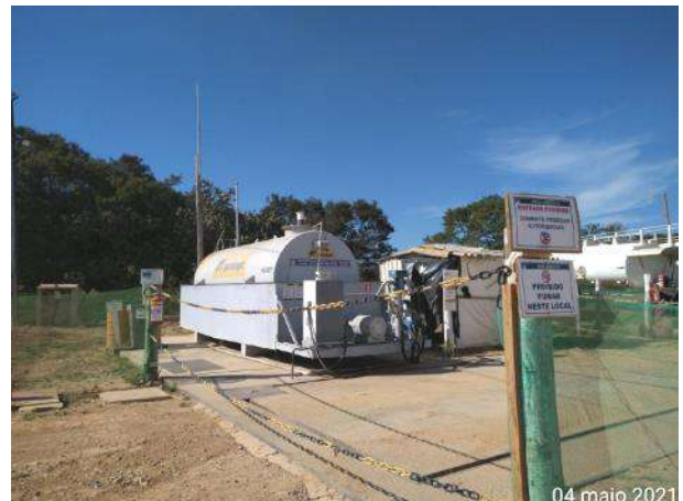
Foto 100 – Posto de abastecimento de combustível. (Data:04/05/2021)
