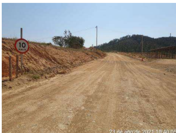
Foto 316 – Sinalização interna de limite de velocidade. (Data:23/08/2021)
