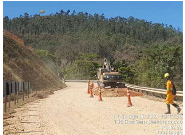
Foto 297 – Isolamento e sinaleiros para atividade em via externa – MD03. (Data:31/08/2021)
