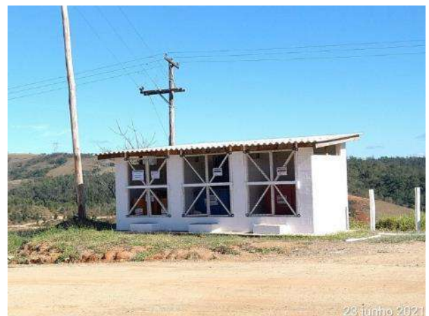
Foto 455 – Baía de resíduo reciclável no canteiro operacional. (Data:23/06/2021)
