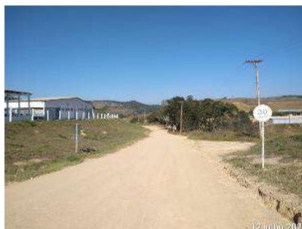
Foto 309 – Sinalização de limite de velocidade em via interna – canteiro operacional. (Data:12/07/2021)
