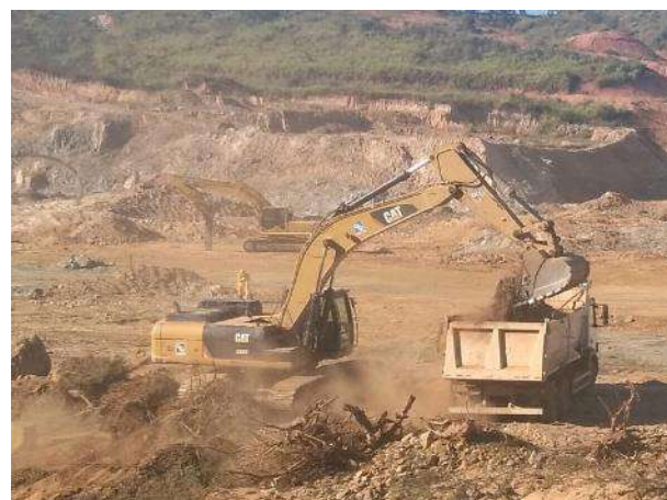
Foto 485 – Movimentação de terra - margem esquerda. (Data:05/06/2021)
