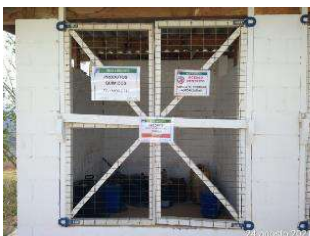
Foto 115 – Armazenamento de produto químico da FG Moretti no canteiro operacional. (Data:24/08/2021)
