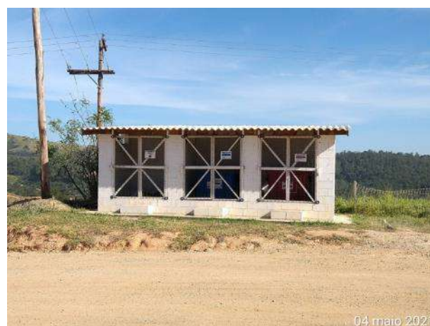
Foto 448 – Baía de resíduos recicláveis no canteiro operacional. (Data:04/05/2021)
