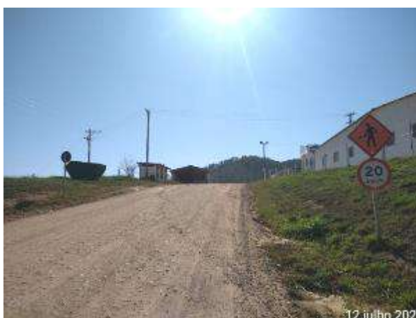
Foto 308 – Sinalização de limite de velocidade em via interna – canteiro operacional. (Data:12/07/2021)
