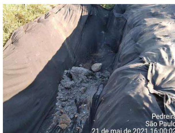
Foto 377 – Área para lavagem da calha de betoneira canteiro operacional. (Data:21/05/2021)
