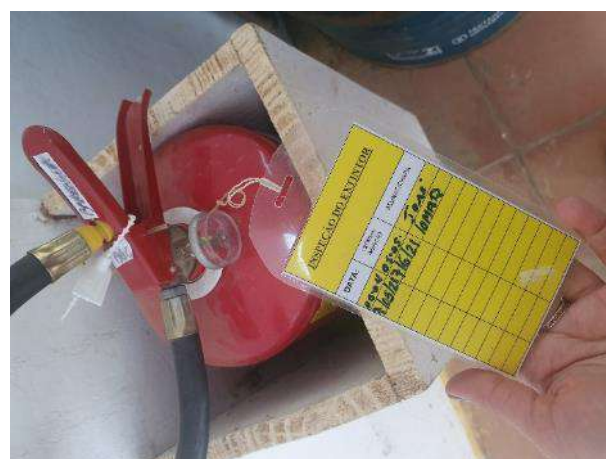
Foto 217 – Inspeção em extintor. (Data:07/05/2021)
