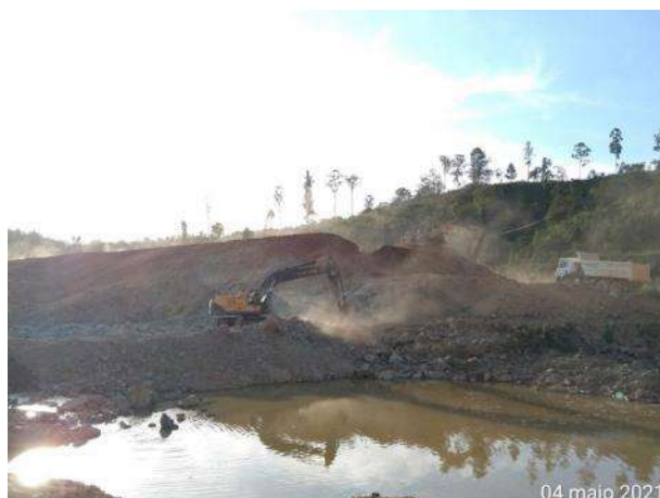
Foto 478 – Movimentação de terra e rocha - margem direita. (Data:04/05/2021)
