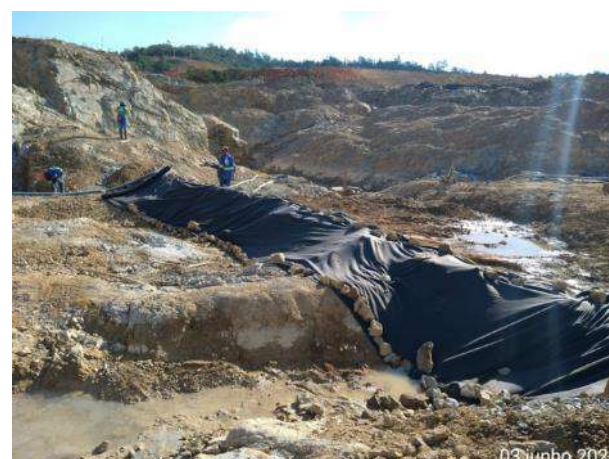
Foto 379 – Dispositivo de drenagem provisória para efluente do processo de sondagem. (Data:03/06/2021)
