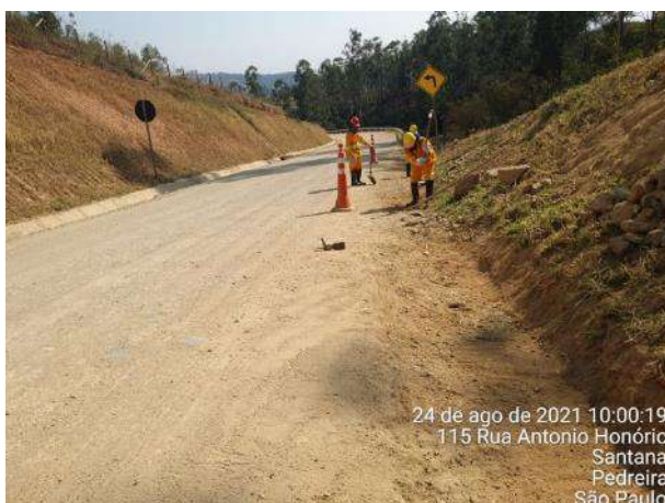
Foto 341 – Implantação de drenagem definitiva no acesso da MD 03. (Data:24/08/2021)
