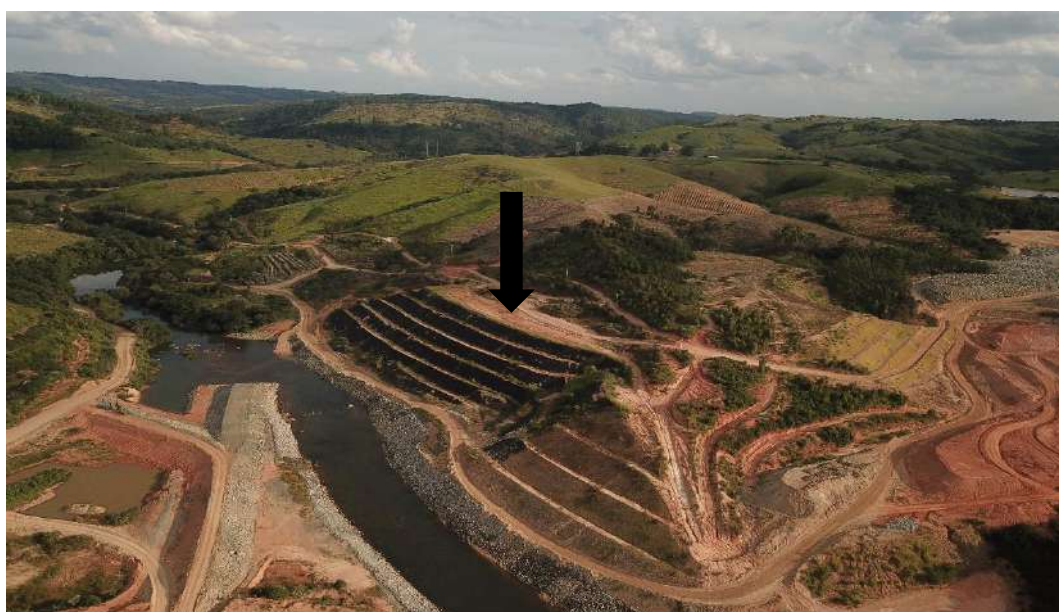
Foto 496 – Bota-fora I margem esquerda. (Data:08/02/2021)
