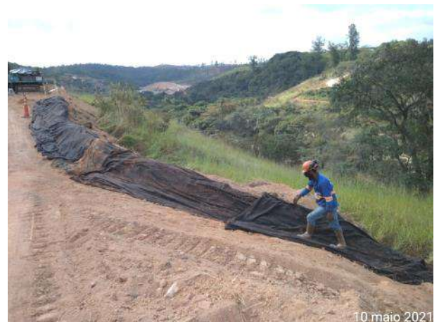
Foto 375 – Dispositivo de drenagem provisória para efluente do processo de sondagem. (Data:10/05/2021)
