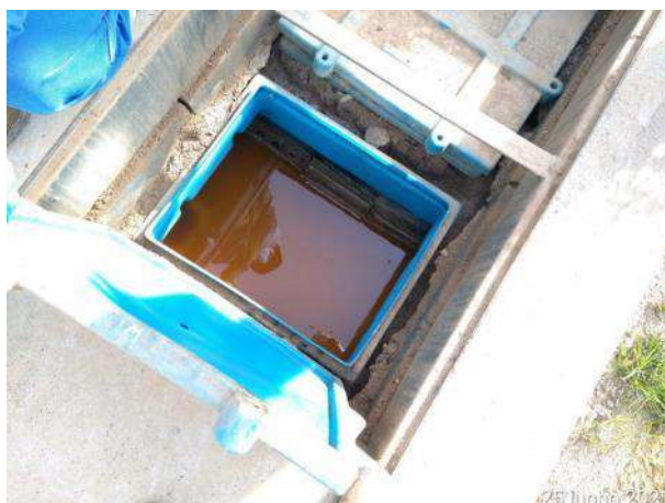
Foto 382 – Inspeção em Caixa SÃO 1. (Data:25/06/2021)
