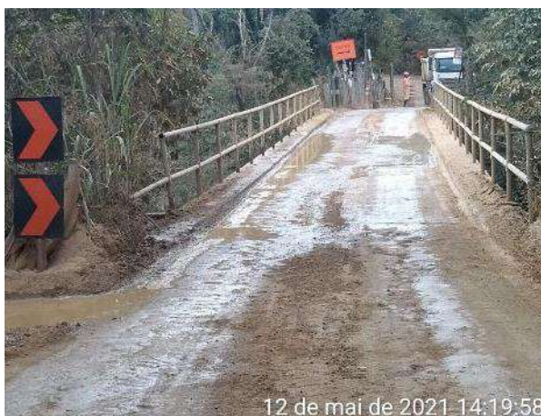
Foto 282 – Sinalização na estrada Sosas-Pedreira. (Data:12/05/2021)
