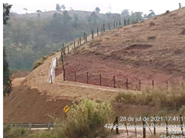
Foto 363 – Inspeção em drenagem da MD03 em dia de chuva. (Data:28/07/2021)
