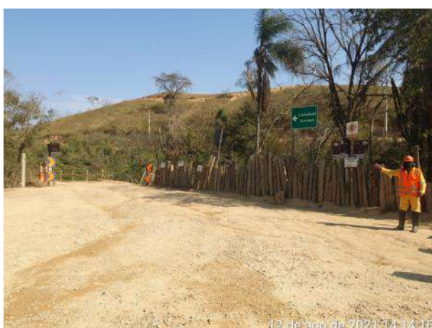
Foto 294 – Sinalização orientando o trânsito no desvio, sentido estrada de Sosas. (Data:12/08/2021)
