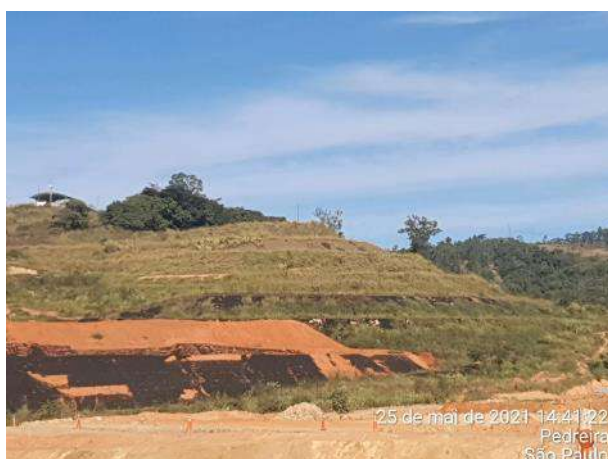
Foto 348 – Inspeção bota-fora I margem direita. (Data:25/05/2021)
