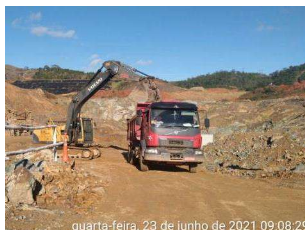
Foto 487 – Movimentação de terra - margem esquerda. (Data:23/06/2021)
