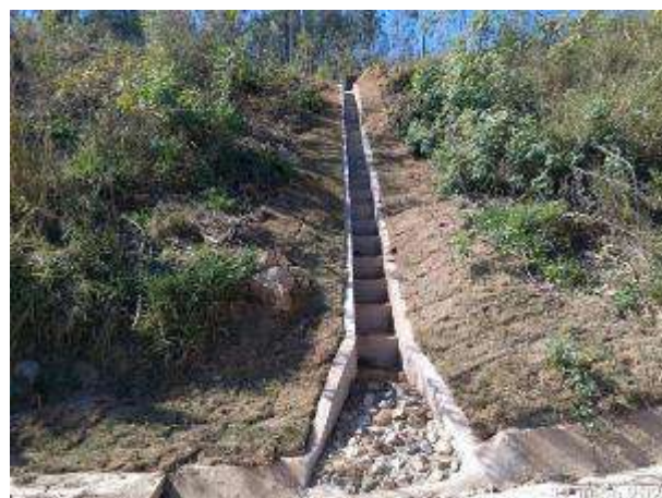
Foto 337 – Escada hidráulica no talude de corte - MD03. (Data:12/07/2021)
