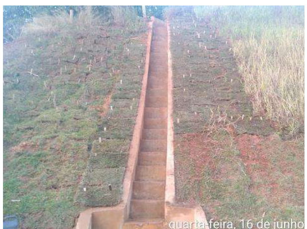
Foto 328 – Escada hidráulica no talude de corte - MD03. (Data:16/06/2021)
