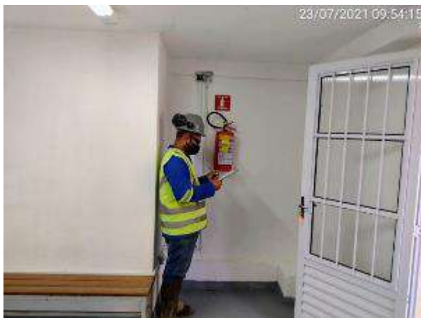
Foto 222 – Inspeção em extintor. (Data:23/07/2021)
