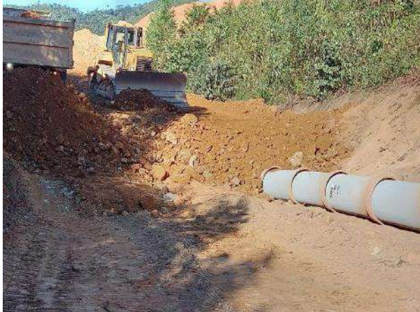
Foto 318 – Drenagem do bota-fora IIB margem esquerda. (Data:17/05/2021)
