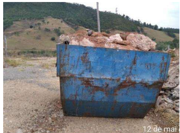
Foto 451 – Caçamba de entulho no canteiro operacional. (Data:12/05/2021)
