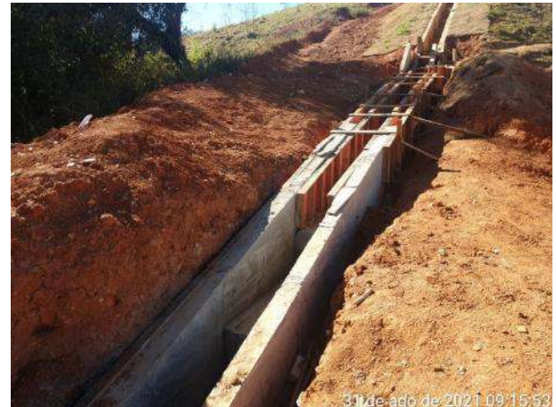
Foto 343 – Finalização da escada hidráulica ombreira direita. (Data:31/08/2021)
