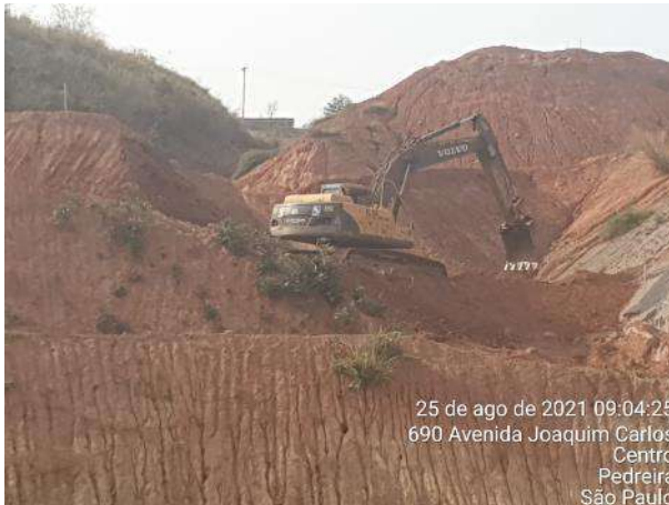
Foto 342 – Implantação de drenagem na margem direita. (Data:25/08/2021)
