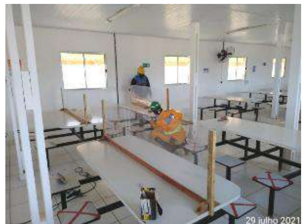
Foto 251 – Instalação de barreira de proteção no refeitório do canteiro operacional. (Data:29/07/2021)
