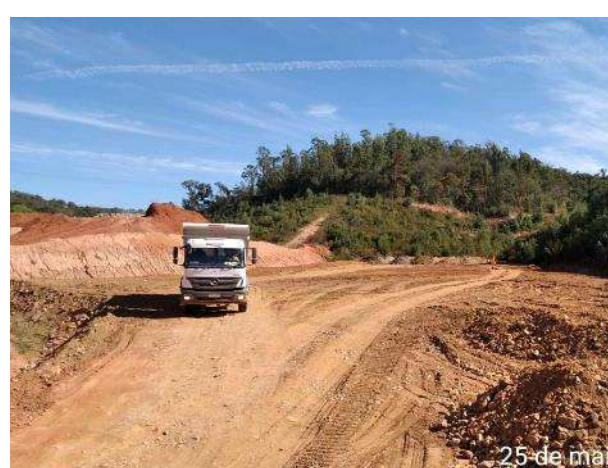
Foto 483 – Movimentação de terra - margem direita (Data:25/05/2021)
