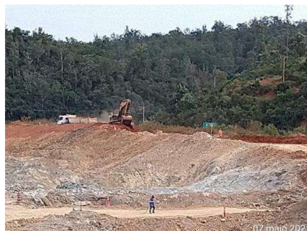
Foto 479 – Movimentação de terra - margem esquerda. (Data:07/05/2021)
