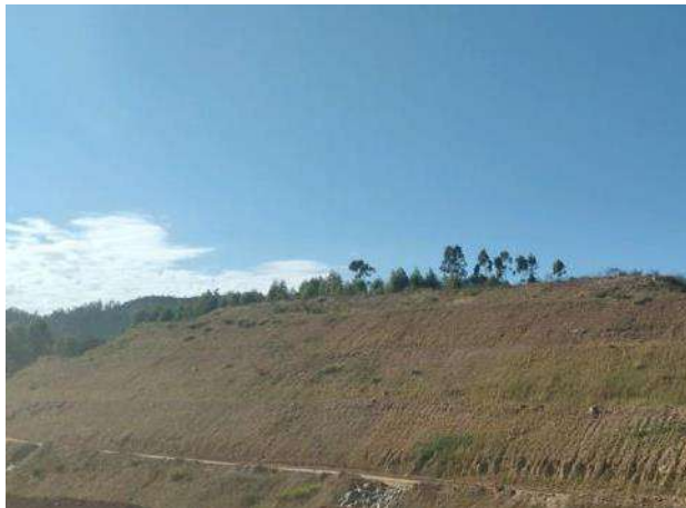
Foto 352 – Inspeção de talude bota-fora II margem esquerda. (Data:09/06/2021)
