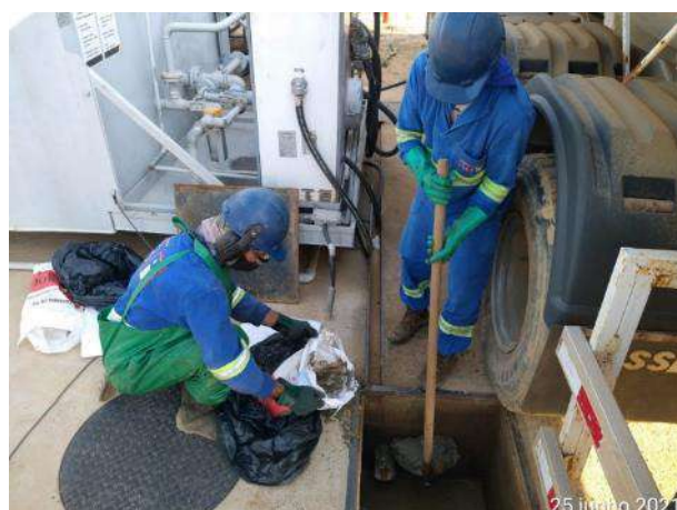
Foto 381 – Manutenção em caixa de inspeção da área de abastecimento. (Data:25/06/2021)
