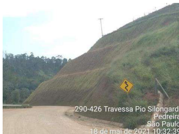
Foto 285 – Sinalização de curva acentuada a direita na estrada municipal de Pedreira. (Data:18/05/2021)
