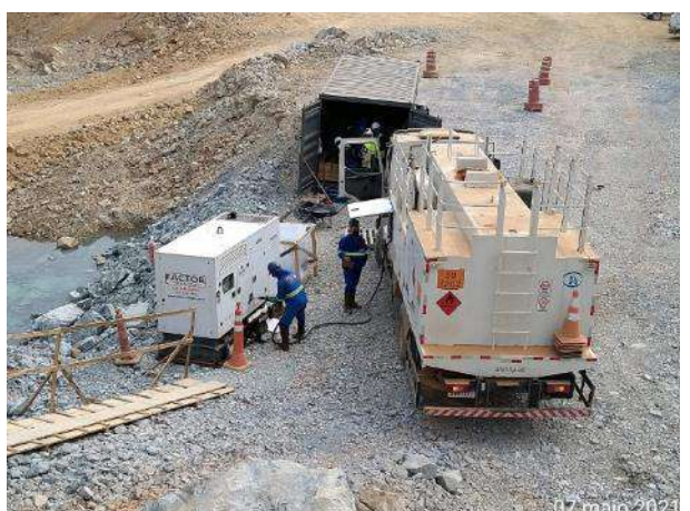
Foto 104 – Abastecimento de gerador na frente de serviço. (Data:07/05/2021)
