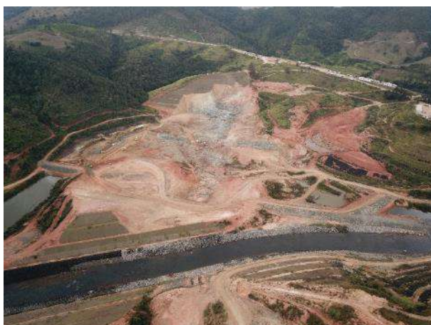
Foto 484 – Visão geral das atividades no empreendimento. (Data:01/06/2021)
