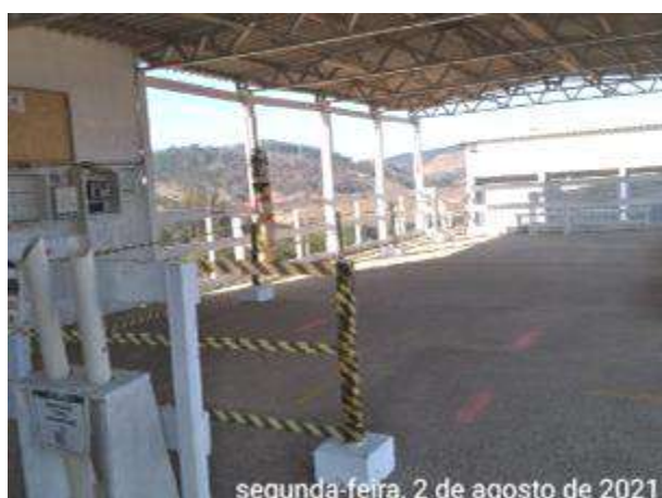
Foto 168 – Área de vivência no canteiro operacional. (Data:02/08/2021)
