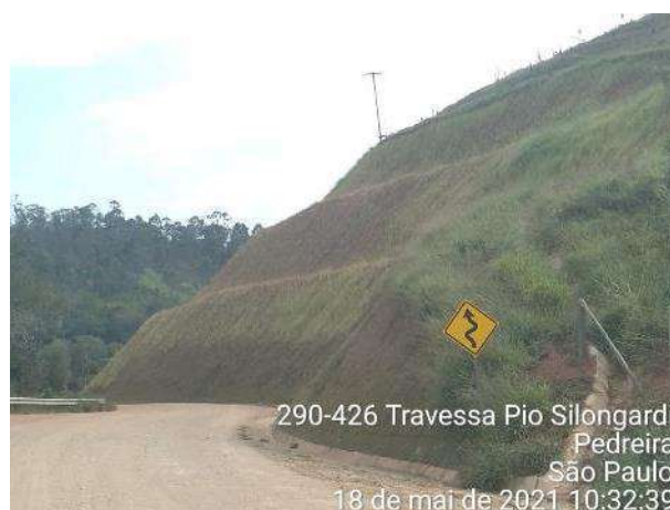
Foto 347 – Inspeção em talude gramado na MD03. (Data:18/05/2021)
