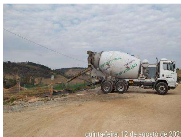
Foto 385 – Lavagem da calha da betoneira. (Data:12/08/2021)
