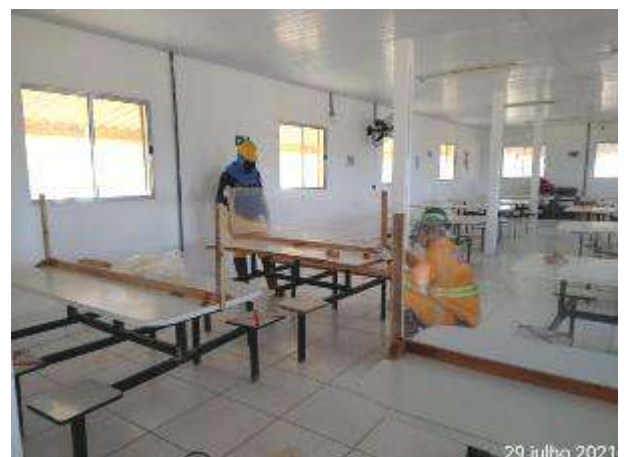
Foto 209 – Utilização de acrílico e madeira para proteção no refeitório do canteiro operacional. (Data:29/07/2021)
