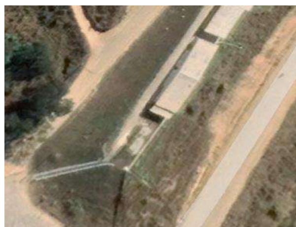
Foto 403- Fossa séptica - canteiro operacional. (Data:31/08/2021)
