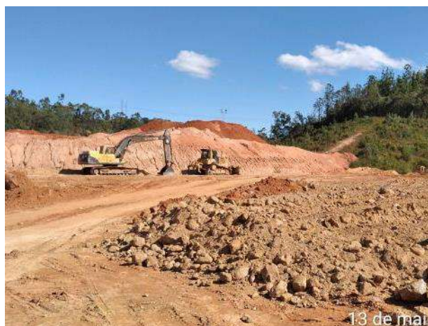
Foto 480 – Movimentação de terra - margem direita. (Data:13/05/2021)
