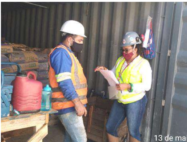
Foto 23 – Treinamento: Levantamento de aspectos e impactos ambientais na atividade de injeção. (Data:13/05/2021)
