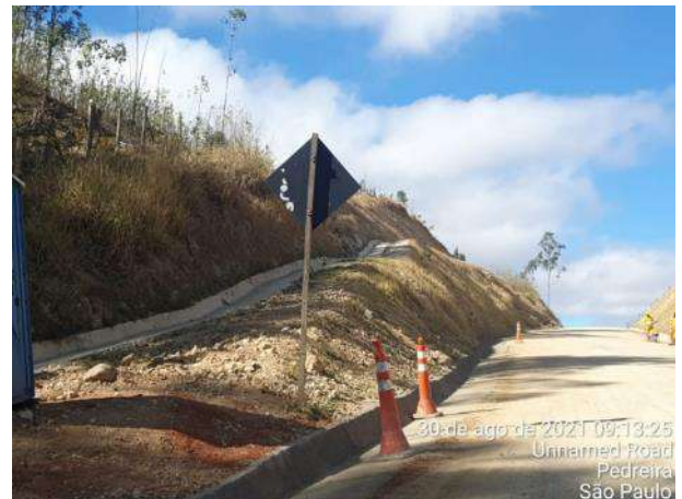
Foto 371 – Inspeção em drenagem permanente – MD03. (Data:30/08/2021)
