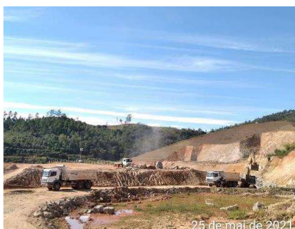
Foto 482 – Movimentação de terra - margem direita. (Data:25/05/2021)
