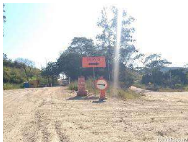
Foto 291 – Sinalização indicando o desvio da estrada municipal em via externa – MD01. (Data:12/07/2021)
