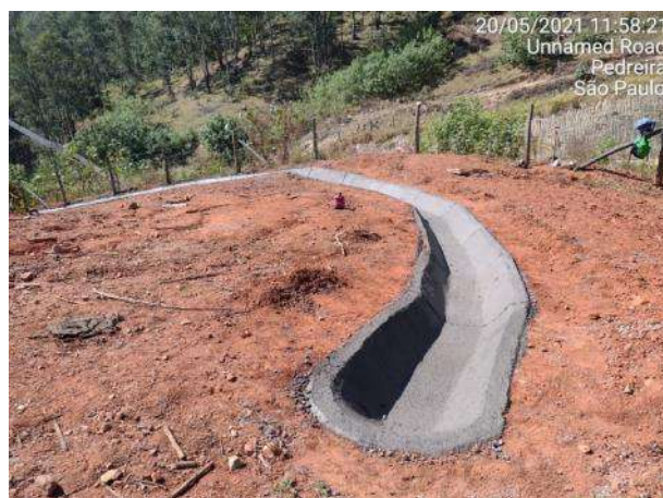
Foto 322 – Drenagem definitiva no acesso da MD03. (Data:20/05/2021)
