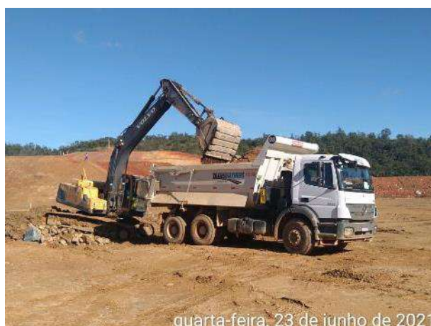
Foto 486 – Movimentação de terra - margem esquerda. (Data:23/06/2021)
