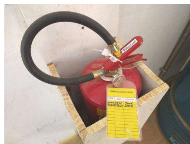
Foto 219 – Inspeção em extintor. (Data:30/06/2021)
