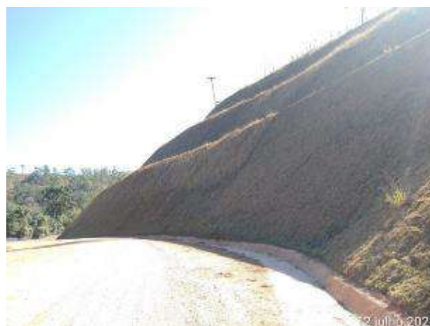
Foto 357 – Inspeção de talude – MD03. (Data:12/07/2021)
