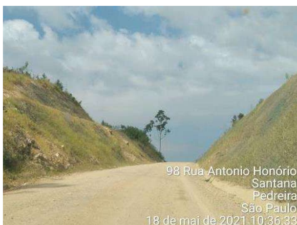
Foto 346 – Inspeção de talude no acesso a MD03. (Data:18/05/2021)
