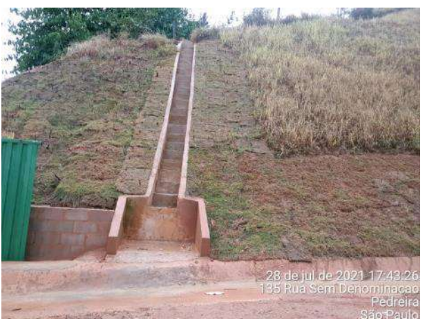
Foto 360 – Inspeção em escada hidráulica em dia de chuva – MD03. (Data:28/07/2021)
