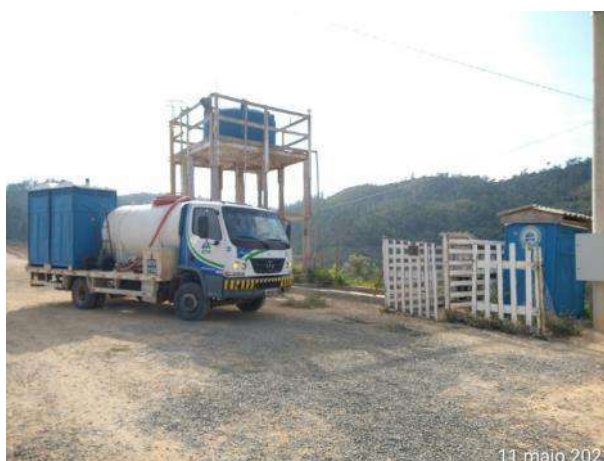
Foto 390 – Registro de higienização de banheiro químico no canteiro operacional. (Data:11/05/2021)
