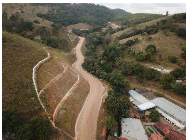
Foto 324 – Vista da drenagem definitiva implantada em talude de corte do acesso – MD03. (Data:01/06/2021)
