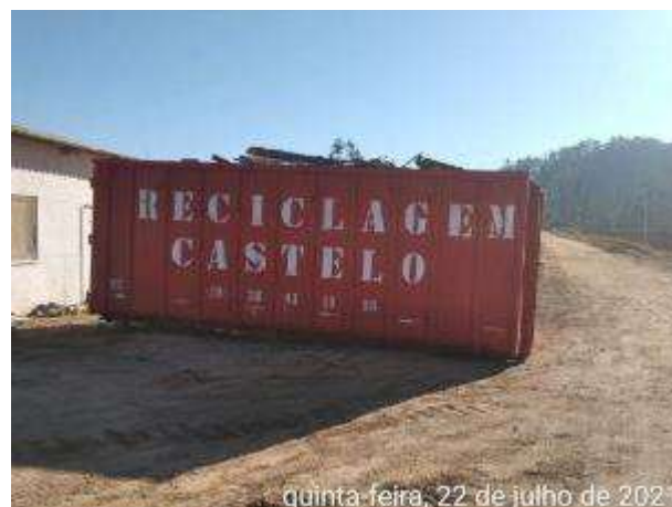
Foto 465 – Caçamba de madeira no canteiro operacional. (Data:22/07/2021)
