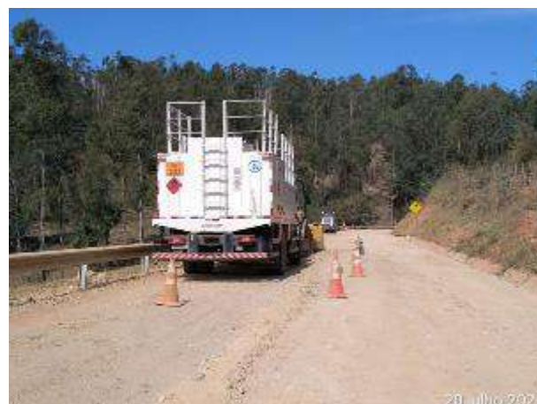
Foto 112 – Abastecimento de equipamento na frente de serviço. (Data:20/07/2021)
