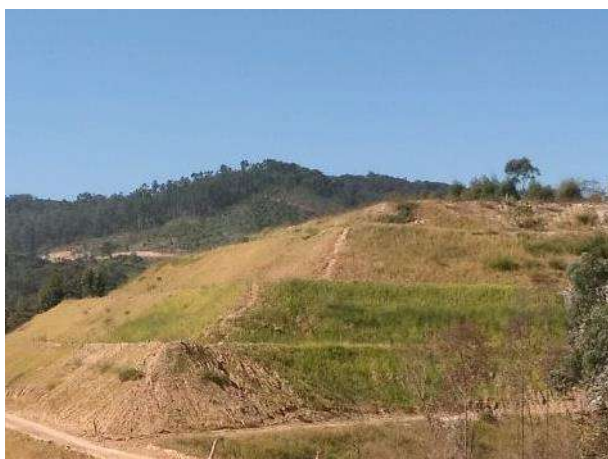
Foto 344 – Inspeção de talude bota-fora II margem esquerda. (Data:03/05/2021)
