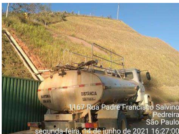
Foto 326 – Irrigação de grama do talude da MD 03. (Data:14/06/2021)
