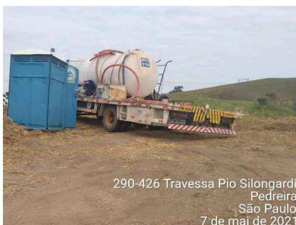
Foto 388 – Registro de higienização de banheiro químico na frente de serviço. (Data:07/05/2021)
