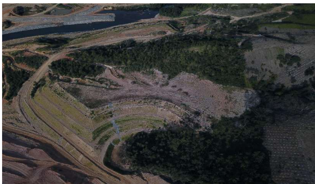
Foto 498 – Bota-fora II A margem esquerda. (Data:15/05/2021)
