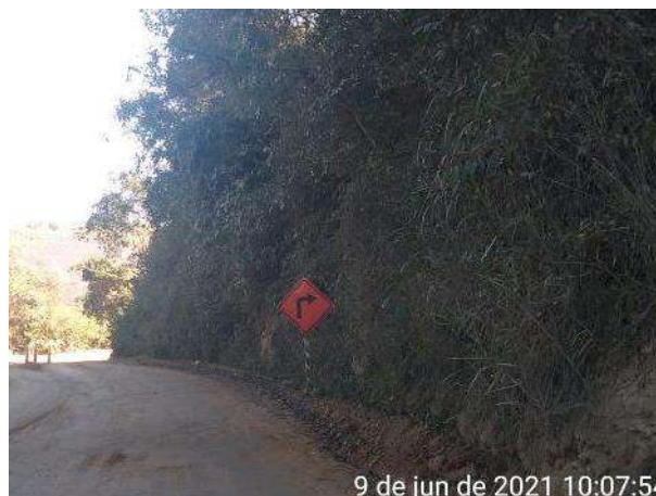
Foto 304 – Sinalização de curva acentuada a direita – acesso margem direita. (Data:09/06/2021)
