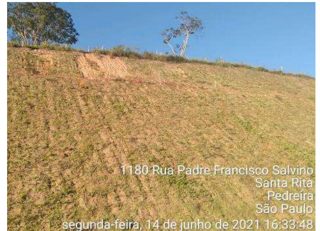
Foto 353 – Inspeção de talude na MD03. (Data:14/06/2021)
