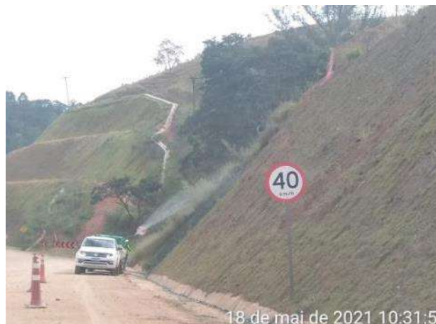
Foto 320 – Hidrossemeadura no acesso da MD03. (Data:18/05/2021)
