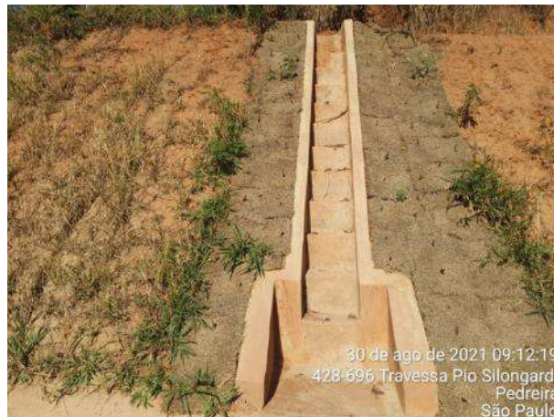
Foto 370 – Inspeção em escada hidráulica pós-chuva – MD03. (Data:30/08/2021)
