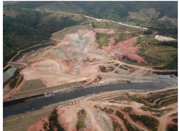
Foto 351 – Inspeção canal de desvio e atividade de tratamento de fundação. (Data:18/06/2021)
