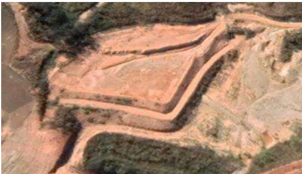
Foto 489 – Bota-espera espaldares sobreposto ao bota-fora I - Margem Direita. (Data:30/07/2021)
