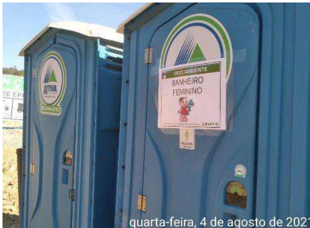
Foto 398 – Banheiro químico feminino na frente de serviço da atividade da fundação. (Data:04/08/2021)
