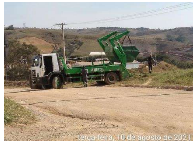
Foto 471 – Troca de caçamba de resíduo comum no canteiro operacional. (Data:10/08/2021)
