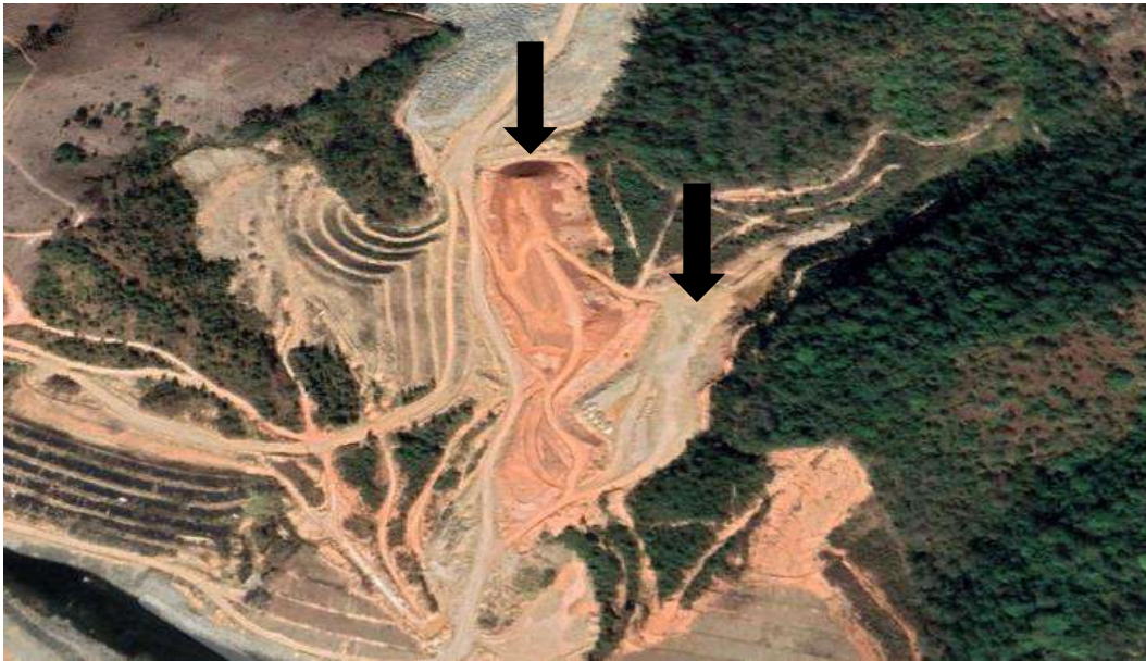
Foto 499– Bota-espera e bota-fora IIB margem esquerda. (Data:23/07/2021)
