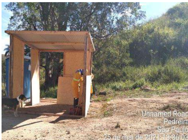
Foto 200 – Reutilização de madeira da supressão obrigatória para estrutura da guarita de controle de acesso ao canteiro operacional. (Data:25/05/2021)
