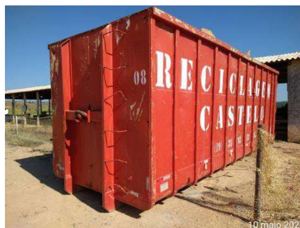
Foto 449 – Caçamba de resíduo de madeira no canteiro operacional. (Data:10/05/2021)
