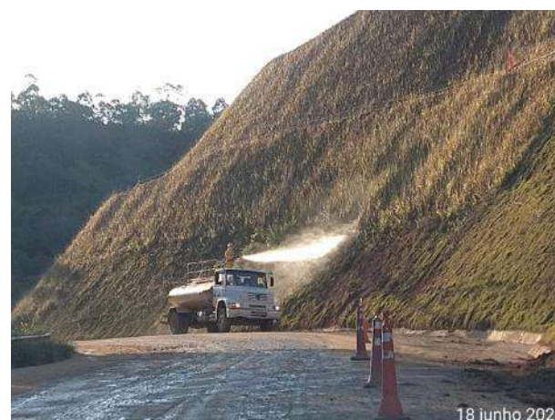
Foto 329 – Irrigação de grama do talude de corte - MD 03. (Data:18/06/2021)
