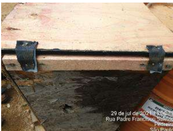
Foto 208 – Utilização de câmara de ar de pneu como dobradiça. (Data:29/07/2021)
