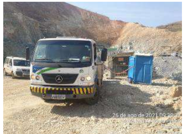
Foto 401 – Limpeza e higienização de banheiro químico na frente de serviço da atividade da fundação. (Data:26/08/2021)
