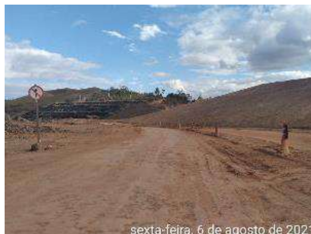
Foto 313 – Sinalização de sentido proibido em via interna. (Data:06/08/2021)
