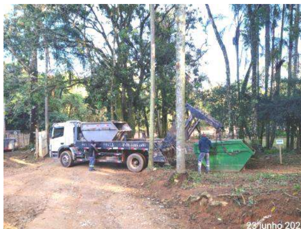
Foto 454 – Troca de caçamba de resíduo comum do canteiro administrativo. (Data:23/06/2021)
