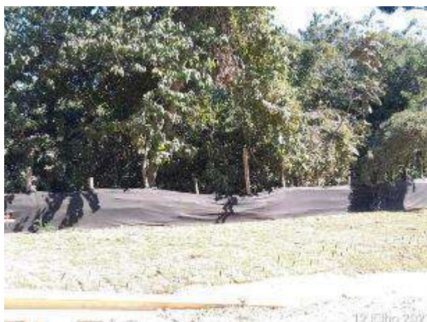
Foto 356 – Inspeção em contenção ambiental na MD03. (Data:12/07/2021)
