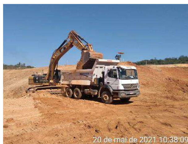
Foto 481 – Movimentação de terra - margem esquerda (Data:20/05/2021)
