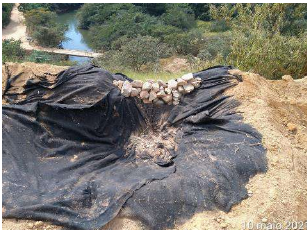
Foto 374 – Dispositivo de drenagem provisória para efluente do processo de sondagem. (Data:10/05/2021)
