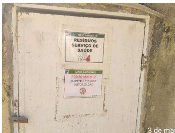
Foto 444 – Baía de resíduo de serviço de saúde no canteiro administrativo. (Data:03/05/2021)
