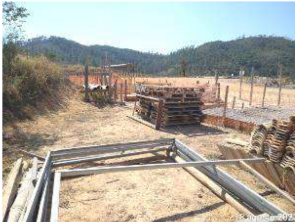
Foto 174 – Organização no armazenamento temporário no canteiro operacional. (Data:18/08/2021)
