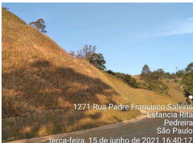
Foto 354 – Inspeção de talude na MD03. (Data:15/06/2021)
