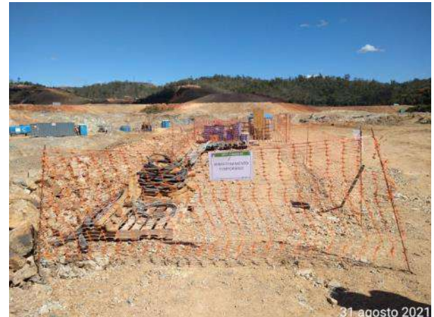
Foto 181 – Organização no armazenamento temporário dos materiais da FG Moretti. (Data:31/08/2021)
