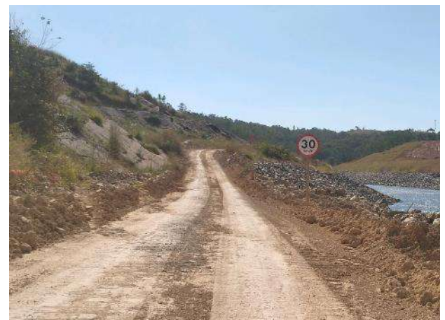
Foto 299 – Sinalização de velocidade máxima permitida na via interna. (Data:03/05/2021)
