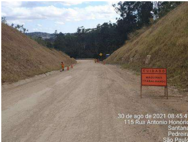
Foto 296 – Sinalização de placa de máquinas trabalhando na via externa – MD03. (Data:30/08/2021)
