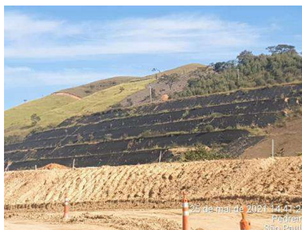
Foto 349 – Inspeção bota-fora I margem esquerda. (Data:25/05/2021)
