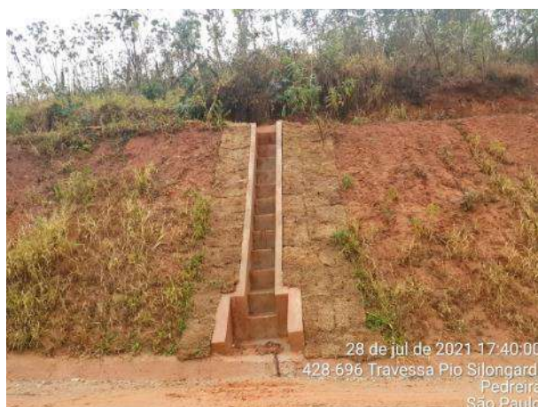
Foto 364 – Inspeção em escada hidráulica em dia de chuva – MD03. (Data:28/07/2021)
