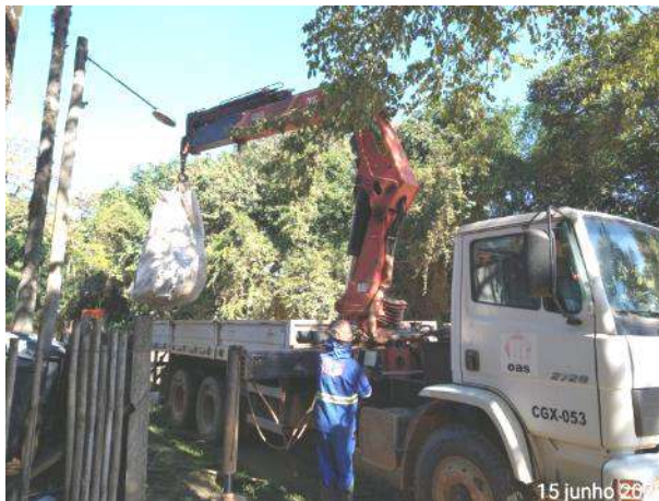
Foto 452 – Retirada de resíduos recicláveis canteiro administrativo para encaminhar a cooperativa de Pedreira. (Data:15/06/2021)
