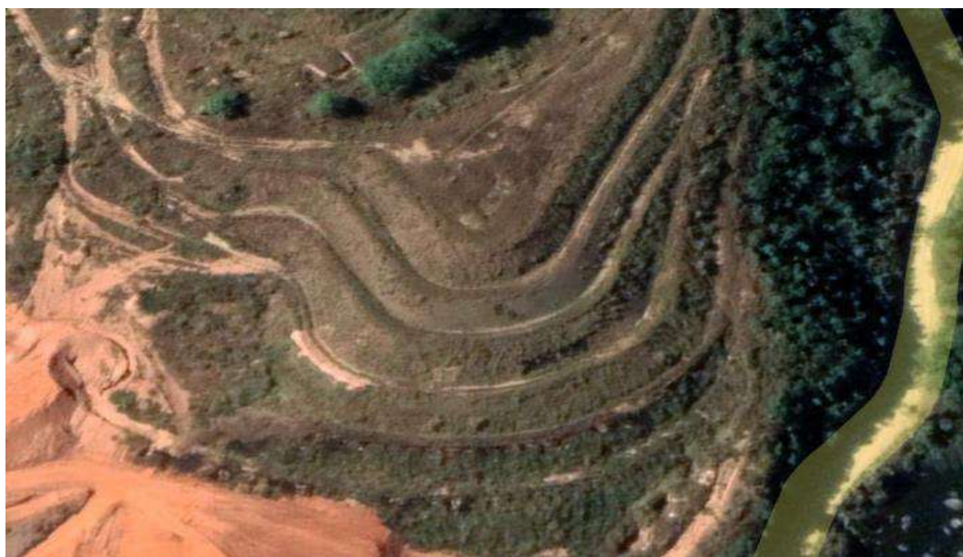
Foto 490 – Bota-fora II Margem Direita. (Data:30/07/2021)
