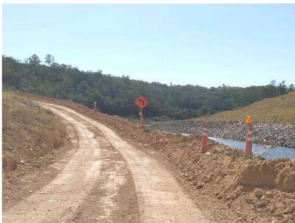
Foto 298 – Sinalização de curva acentuada no acesso ao bota fora II M.E. (Data:03/05/2021)
