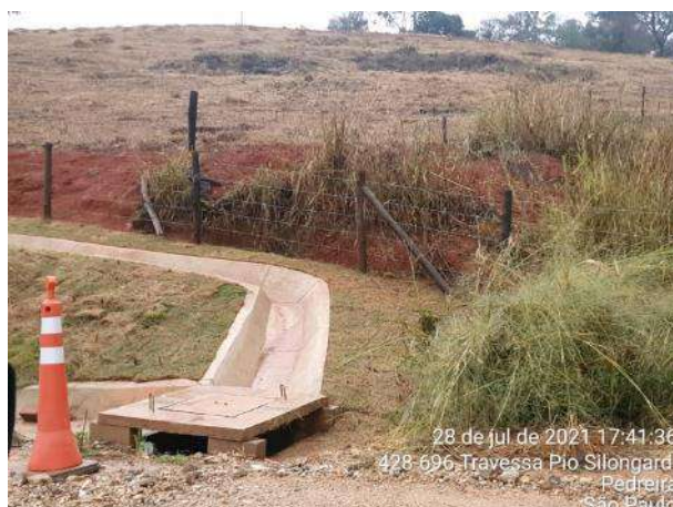
Foto 362 – Inspeção em drenagem da MD03 em dia de chuva. (Data:28/07/2021)
