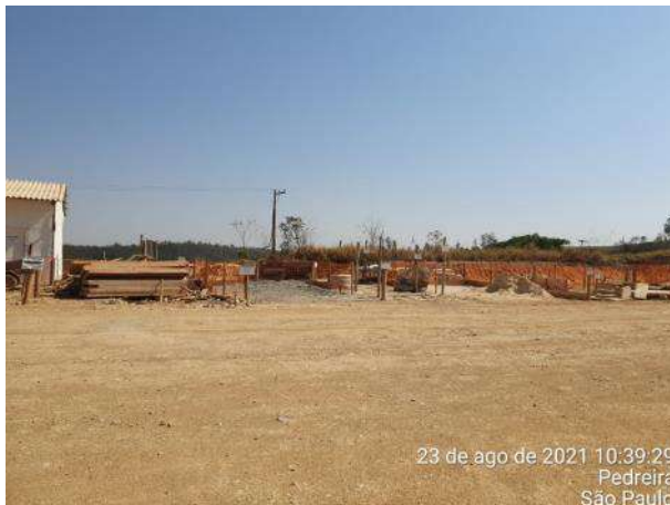
Foto 176 – Organização no armazenamento temporário de materiais no canteiro operacional. (Data:23/08/2021)
