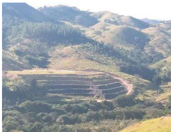
Foto 345 – Inspeção de talude bota-fora VII margem direita. (Data:08/05/2021)
