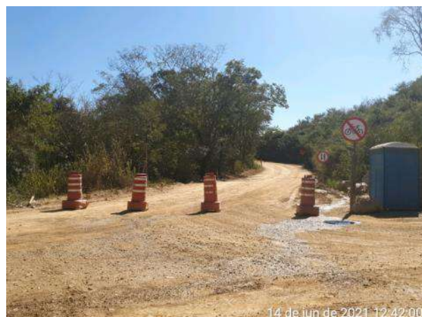
Foto 287 – Sinalização de cones – acesso margem direita. (Data:14/06/2021)
