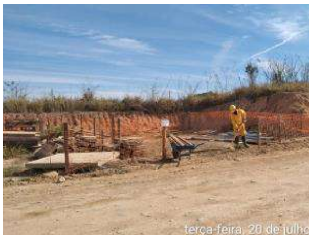
Foto 158 – Organização e limpeza no canteiro operacional. (Data:20/07/2021)
