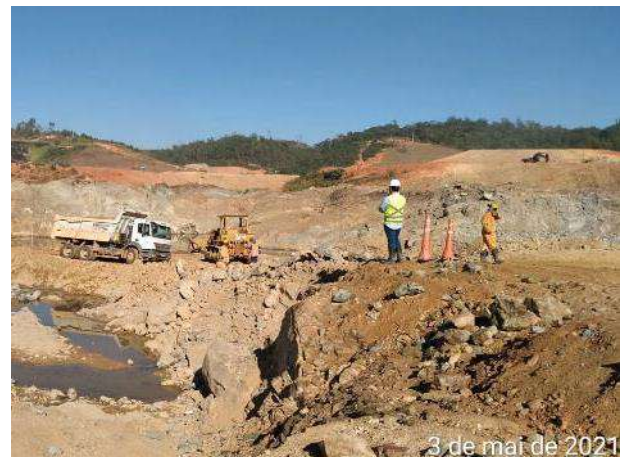
Foto 477 – Movimentação de terra e rocha - margem direita. (Data:03/05/2021)
