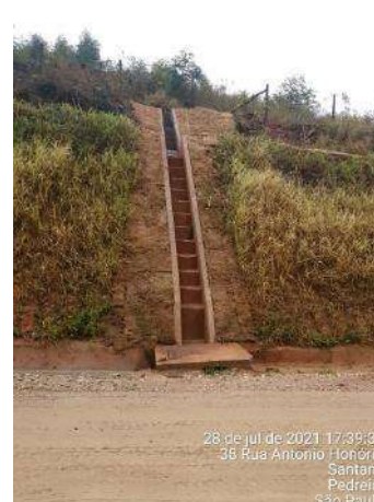
Foto 365 – Inspeção em drenagem em dia de chuva – MD03. (Data:28/07/2021)
