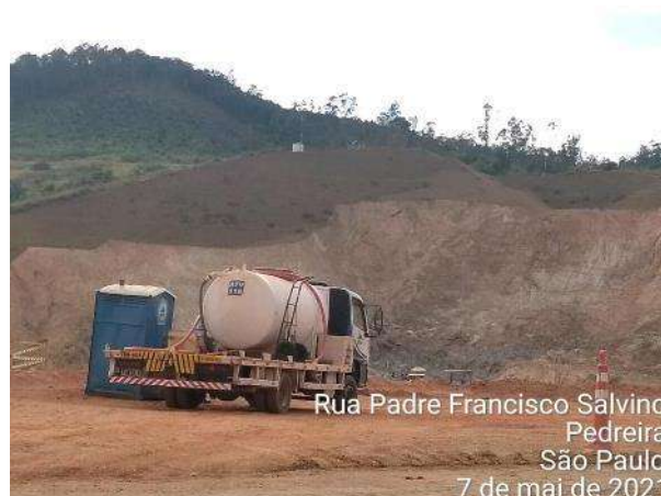
Foto 389 – Registro de higienização de banheiro químico na frente de serviço. (Data:07/05/2021)
