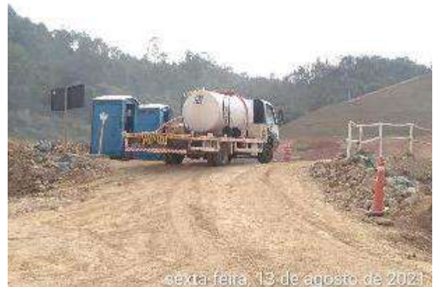
Foto 399 – Higienização de banheiro químico na frente de serviço da atividade da fundação. (Data:13/08/2021)
