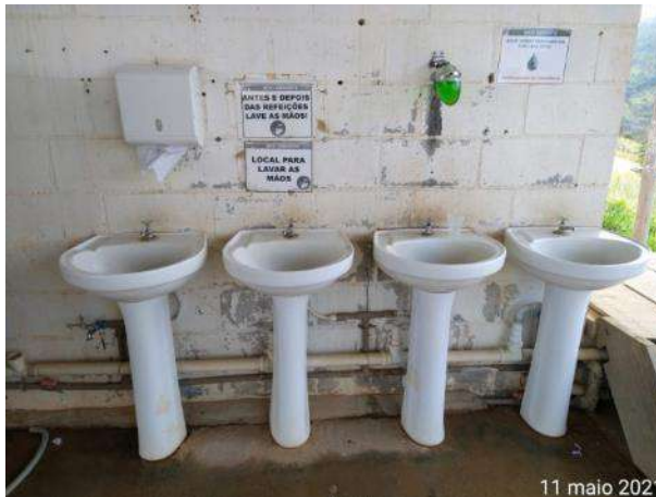
Foto 142 – Área para higienização das mãos ao lado do refeitório do canteiro operacional. (Data:11/05/2021)
