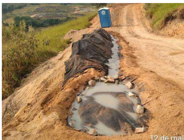
Foto 376 – Dispositivo de drenagem provisória para efluente do processo de sondagem. (Data:12/05/2021)
