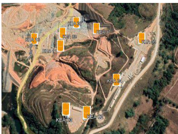
Figura 8 —Indicação dos kits de emergência ambiental na margem direita.
