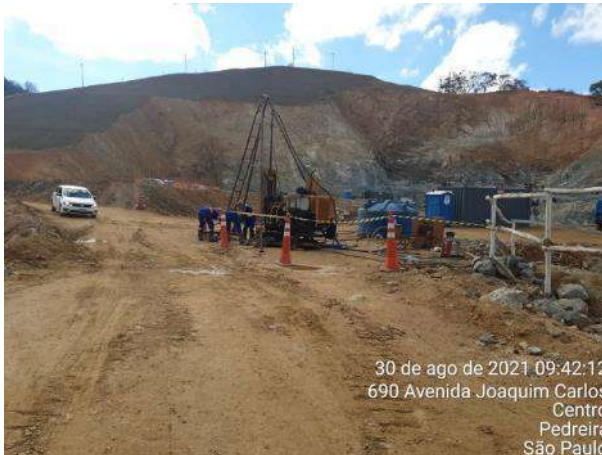
Foto 180 – Organização na atividade de sondagem. (Data:30/08/2021)
