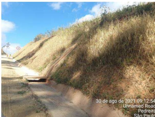
Foto 372 – Inspeção em drenagem permanente – MD03. (Data:30/08/2021)
