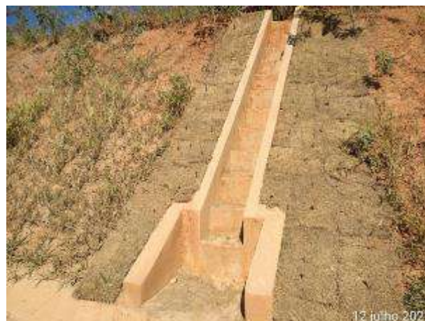
Foto 335 – Escada hidráulica no talude de corte - MD03. (Data:12/07/2021)
