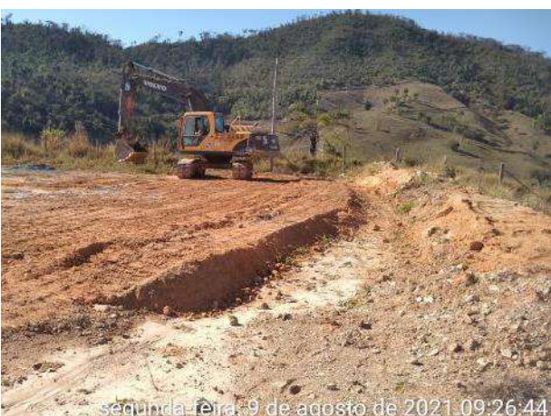
Foto 340 – Implantação de drenagem provisória canteiro operacional. (Data:09/08/2021)
